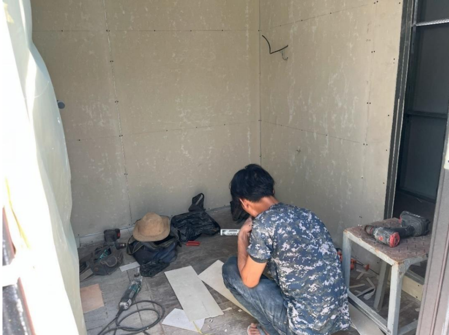
Lampiran 31 Gambar 4.2.9 Pemasangan Dinding GRC Board
