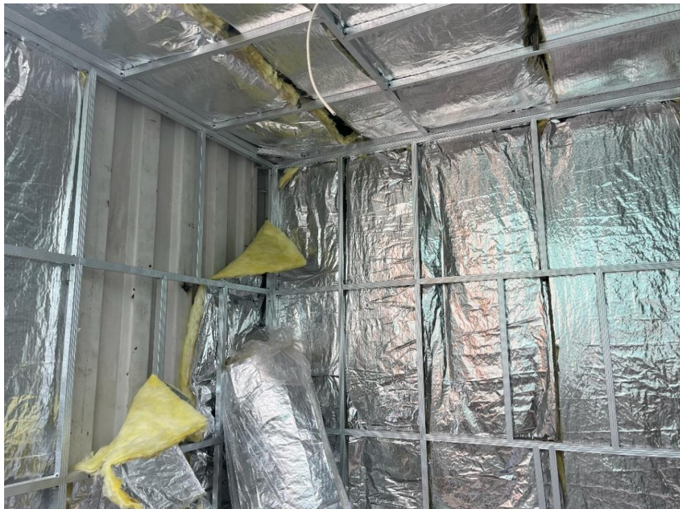
Lampiran 28 Gambar 4.2.6 Pemasangan Insulasi Termal
