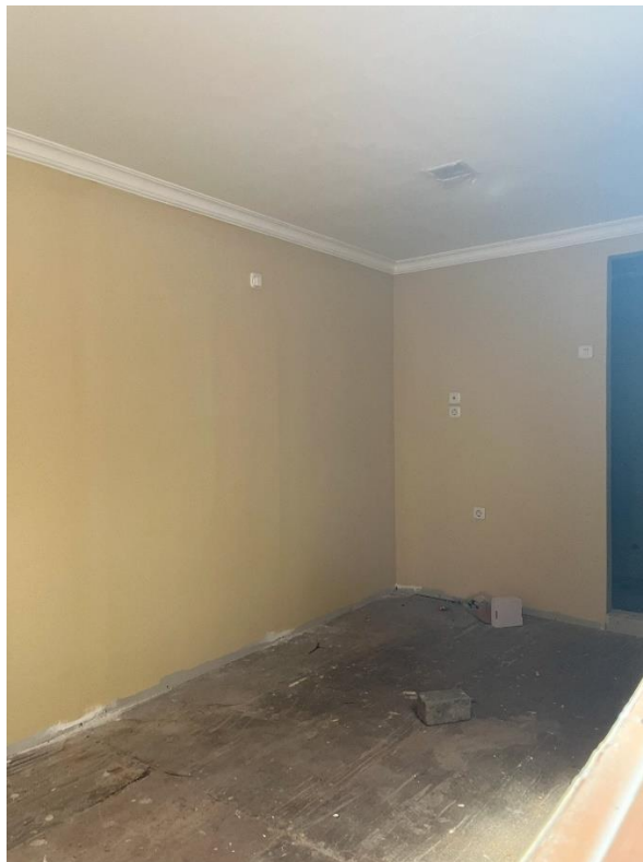
Lampiran 32 Gambar 4.2.10 Finishing Dinding dan Plafond
