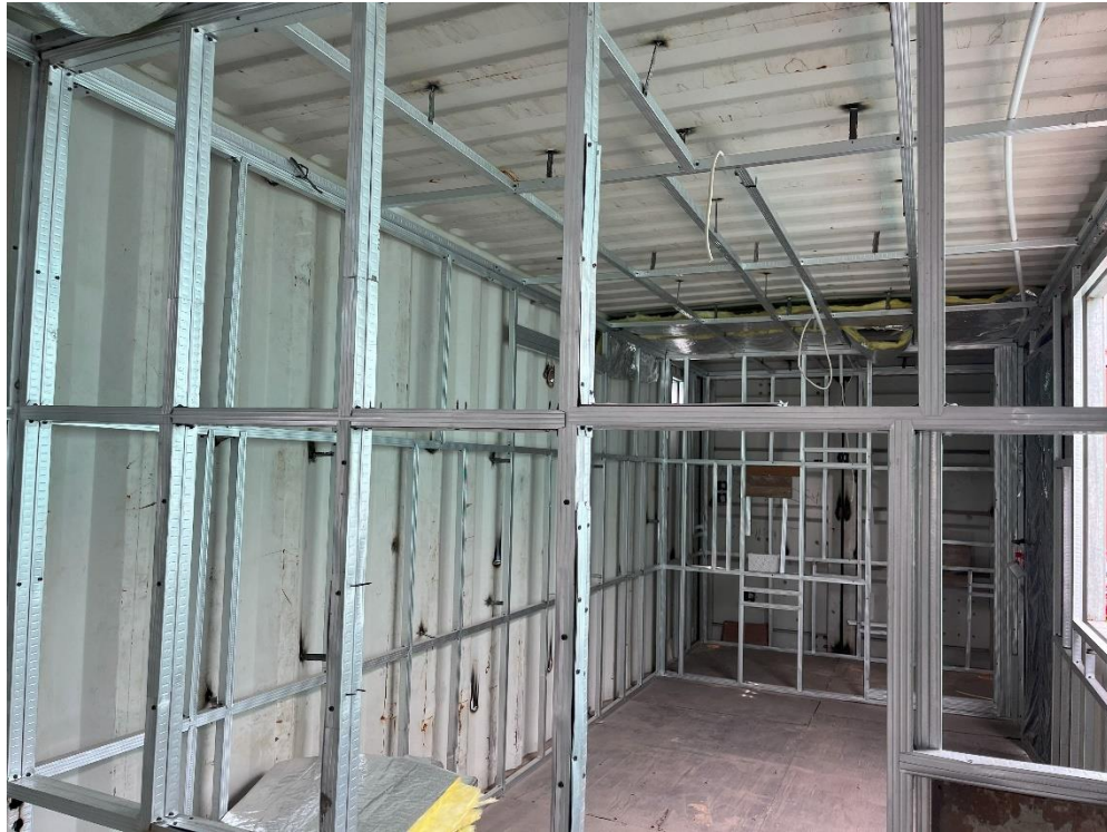
Lampiran 27 Gambar 4.2.5 Pemasangan Kerangka Interior Dengan Material Baja Ringan Hollow Galvalum
