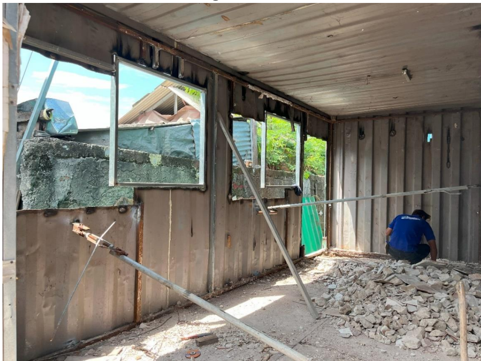
Lampiran 24 Gambar 4.2.2 Pemotongan dan Pembobokan Kontainer
