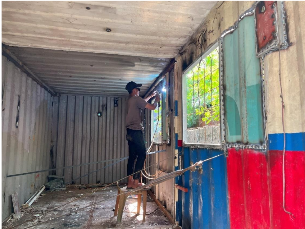
Lampiran 25 Gambar 4.2.3 Pemasangan Kerangka Ventilasi
